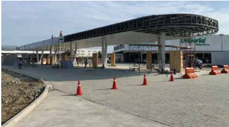
ESTACIÓN DE SERVICIO PRIMAX LA MODERNA
